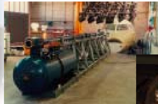
Interno della "Test House" di Aermacchi; in primo piano il sistema pneumatico di lancio.
