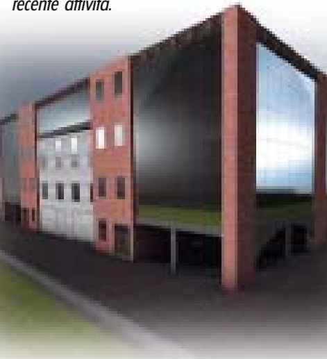
Nuova sede di Como, in fase di realizzazione
